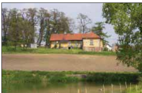
Dwór w Skrzyszowicach
