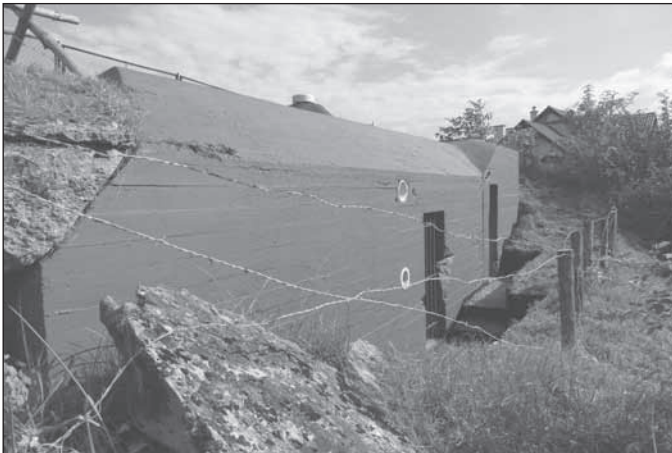
Schron bierny Regelbau 668 ze stanowiskiem bojowym Ringstand 58c, „Punkt oporu Rudawa”, fot: Dariusz Krzyształowski
