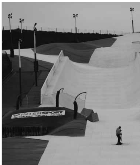
Obiekt Loisirnd. Przykład zaadoptowania kopalnianych pozostałości na obiekty sportowe.
